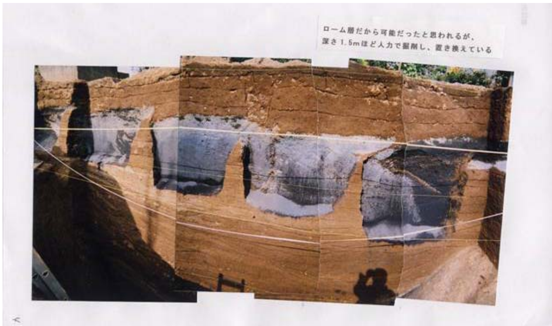
写真1 “天地返し” の掘削断面
