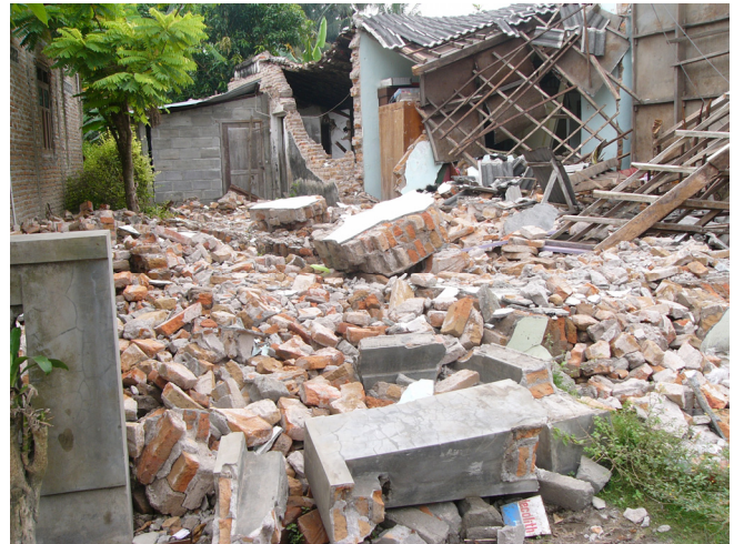
図 6 崩壊したレンガ造りの家屋(バントゥール県).
