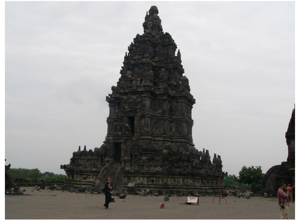
図 5 軽微な被害を受けたヒンズー教プランバナン寺院中の1つのお寺. お寺の敷地内には, 寺院の飾りや壁から落ちた石の破片が散乱していた.
