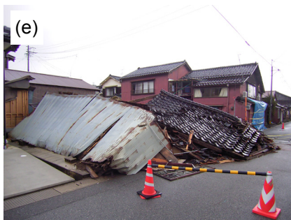
写真5 輪島市鳳至町（震度6強）において、倒潰して道路にせり出した木造住宅。
