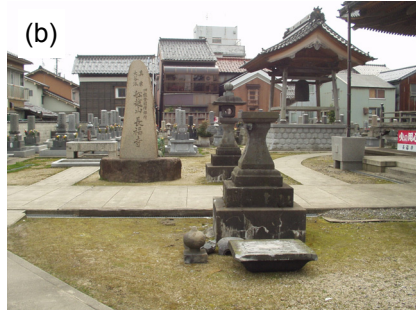
写真2 七尾市役所（震度5強）付近の寺院内の石灯籠頭部の落下。社務所の玄関ガラスも破損した。
