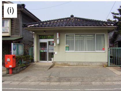
写真 9 輪島市門前町道下地区において外観上無被害の木造の郵便局。
