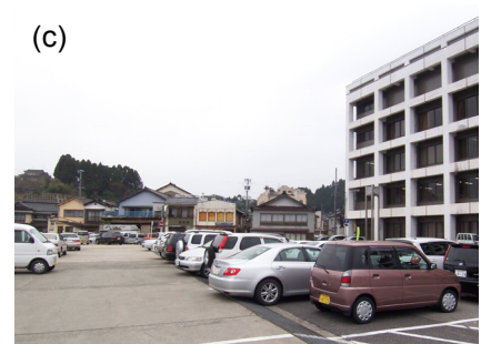
写真3 能登町役場（震度6弱）の周辺の状況。住宅外観に被害は見られない。
