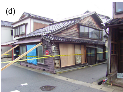
写真4 輪島市河井町（震度6弱）において大傾斜した木造住宅。
