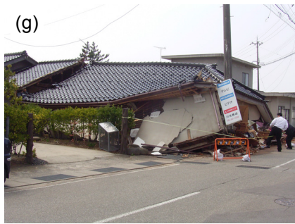
写真 7 輪島市門前町（震度 6 強）において完全に倒潰した木造住宅。
