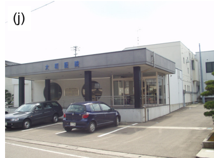
写真 10 輪島市門前町道下地区において外観上無被害の RC 造医院。
