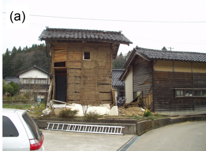
写真1 氷見市姿地区（震度5弱～5強）における土蔵外壁の崩落。隣の住宅にも被害が見られる。
