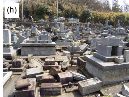
写真 8 輪島市黒島町の高台にある福善寺墓地の状況. 墓石の 9 割程度の転倒が認められる。
