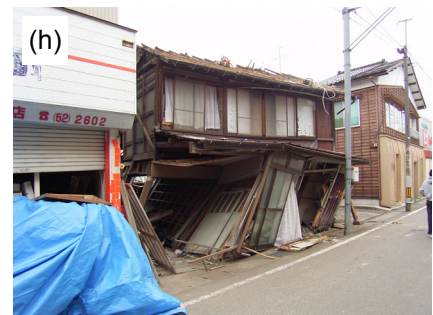
写真6 穴水町（震度6強）における倒潰寸前の木造住宅。
