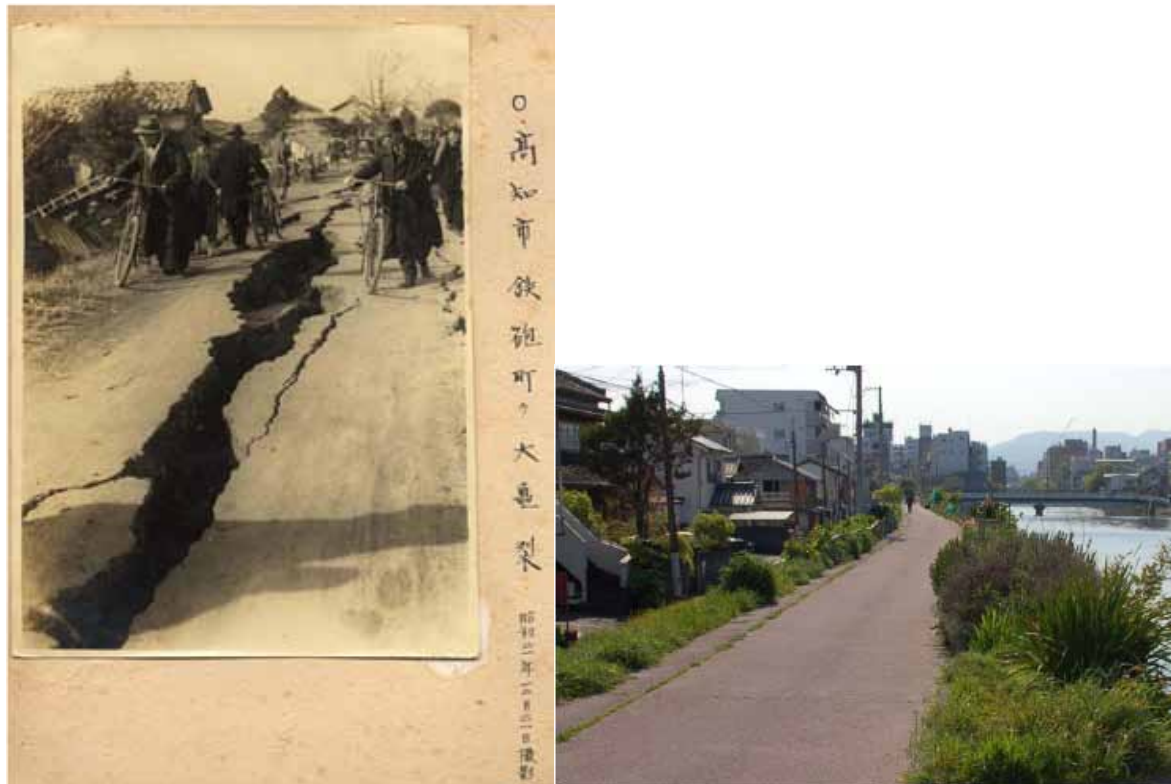
図4 江ノ口川堤防に発生した大亀裂
