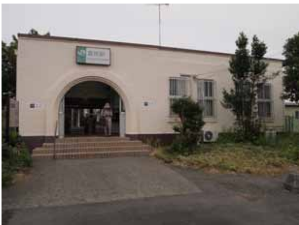
図 22 震災後鉄筋コンクリートの耐震構造で建てられた倉見駅の駅舎
