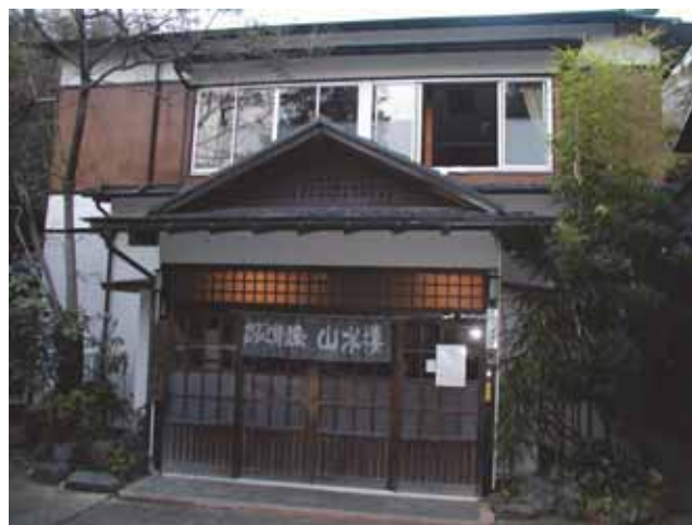
図17 関東大震災で湧き出したかぶと湯温泉
