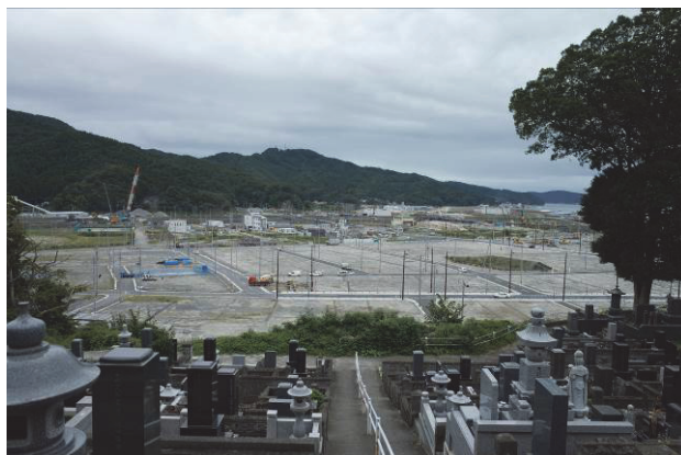
写真 1. 城山から見下ろす復興工事中の町方地区
