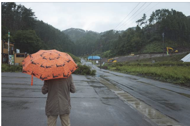
写真4. 小枕地区の造成工事。
