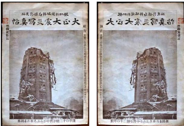
図5(左),図6(右)八階付近で折れた浅草の十二階(凌雲閣).左は裏焼きで,右が正しい像
