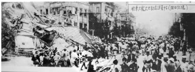
図4 岡田紅陽が撮影した日本橋のビル倒壊生き埋め現場の2枚をつなげたもの
