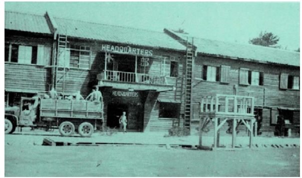
図5. 田辺引揚寮のGHQ事務(HEADQUARTERS).『引揚港 田辺』口絵写真引用
