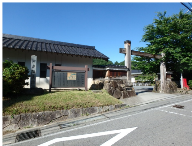
図 10 復元された阿島陣屋 Fig.10 Restored Ajima Jinya. (Takagi village)
