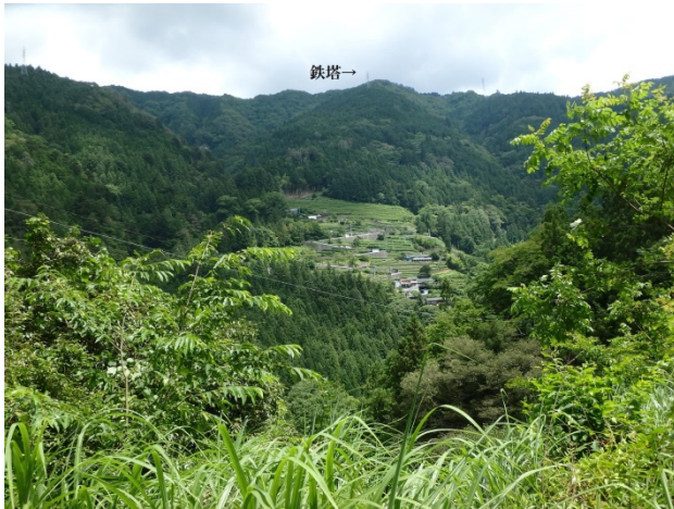
図 3 天龍村十久保 正面の山に立つ鉄塔付近で地割れが発生, 正面の集落と水田が被害を受けた斜面
